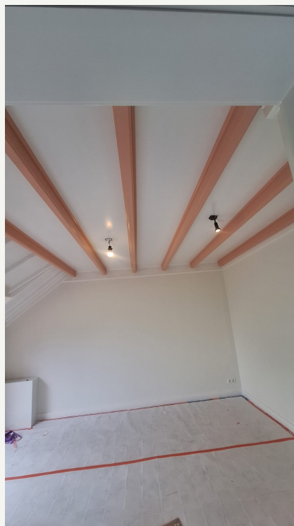
Балки после покраски
